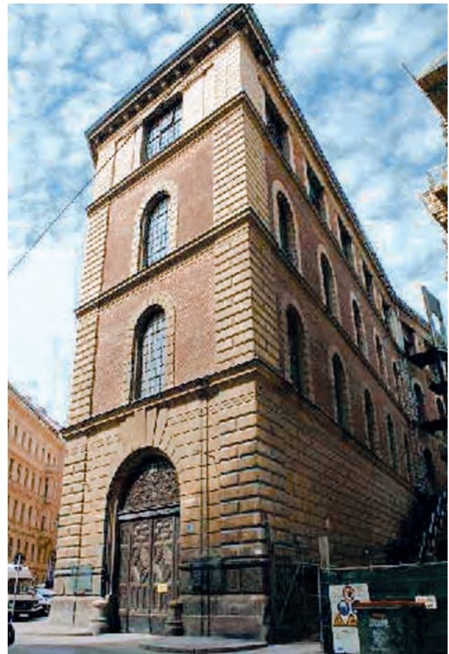
Fig. 4 - Almacenes del Court Teatre di Vienna, 173. La magnífica fachada edificada con ladrillos y elementos en Cemento Romano-
