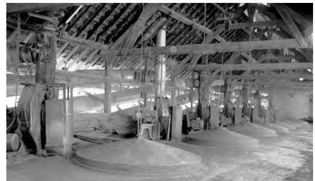
Fig. 22 - Hornos verticales para producción de cemento natural (Ciments Vicat, Grenoble)
