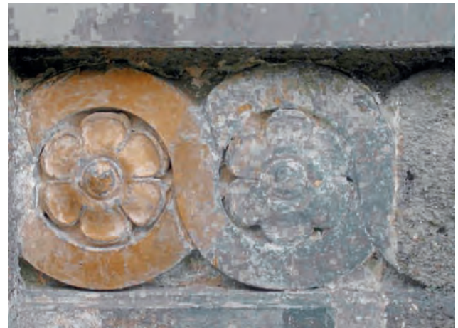
Fig. 16 - Decoraciones en Roman Cement Fig. 17 - Aspecto de la masa en sección transversal pulida
