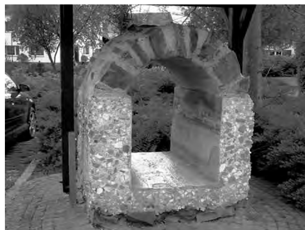
Fig. 2 - Opus caementitium romano, utilizado para construir acueductos a partir del siglo III a.C.
